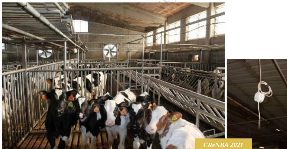
Figura 53 - Condizioni microclimatiche ottimali per gli animali: es. presenza di impianti di condizionamento del microclima con sistemi di controllo automatizzati.
