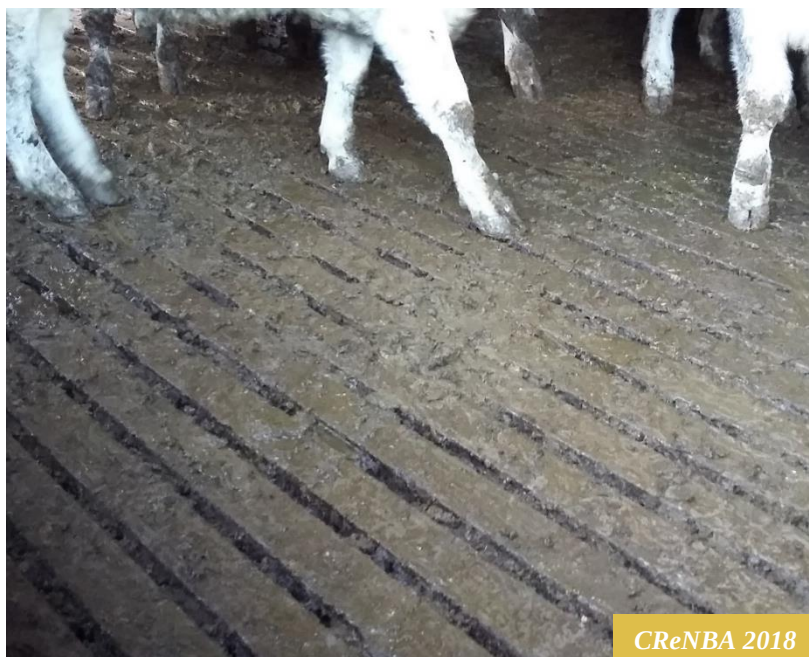
Figura 22 - Esempio di pavimento fessurato non rivestito in gomma.
